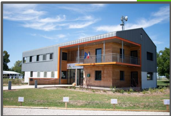
L'hôtel communautaire de la Communauté de communes de la Beauce Loirétaine à Sougy, une construction passive pour laquelle des ressources en bois et paille locales ont été utilisées.
